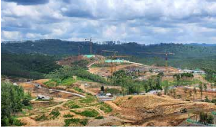
▲인도네시아 신수도 예정지 누산타라의 대통령궁 공사 현장 [연합뉴스 자료사진]
