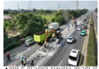
▲반뜰주 땅그랑의 자카르타-땅그랑 유료 도로의 도로 보수 공사 모습 (사진: 자사 마르가)
