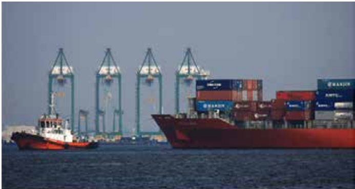
▲북부자카르타 판중브리옥 자카르타국제컨테이너터미널JICT (사진=자카르타경제신문/Aditya)
