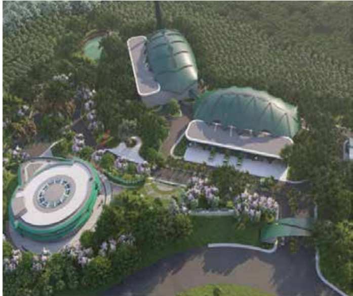
▲인도네시아 신수도 누산따라(IKN) 소각시설 설치 공사 현황(사진=엔씨파워)
