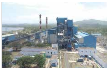
아우랑 화력발전소 (보유지분98%, EPC수행)
