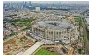
▲북부자카르타 판중뿌리옥에 건설 중인 자카르타 국제 스타디움
