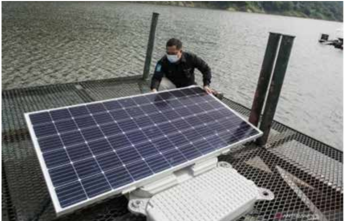
▲ 인도네시아에 동남아 최대 수상 태양광발전소 건설 시작 [안타라통신 · 재판매 및 DB 금지]
