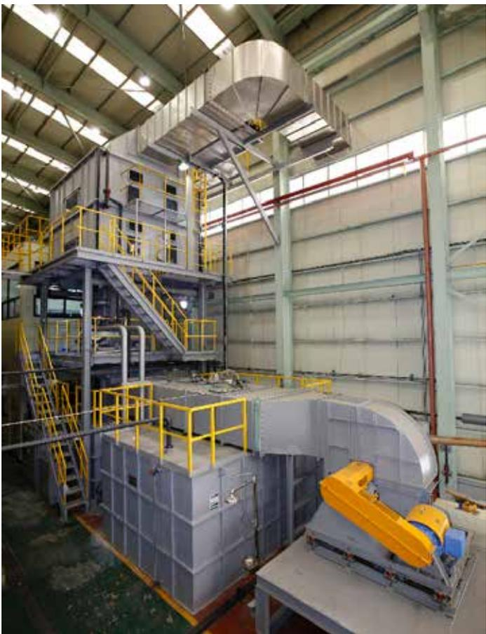
▲ 경남 창원 두산중공업 본사에 설치된 국내 표준 석탄화력발전소용 파일럿(Pilot) EME (Electrostatic Mist Eliminator, 정전기를 이용한 고효율 습분제거기)
